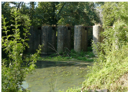
Ouvrage "anti-retour" sur la Cisse, vu de l'amont
