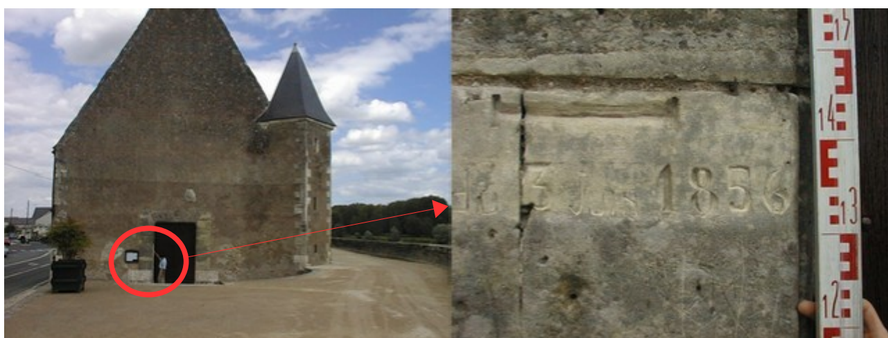
Repère de crue - Église de Notre-Dame du bout des ponts, Amboise
